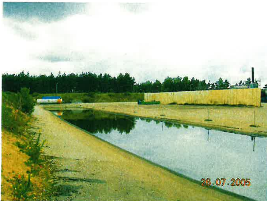
Bild Nr. 2: Sammelbecken Oberflächenwasser, Wasserreinigungsanlage
