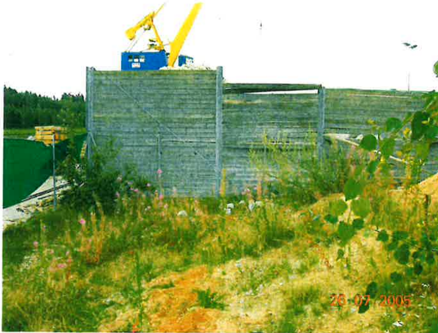
Bild Nr. 1: Lage der Rammkernsondierung 3, außerhalb der asphaltierten Fläche
