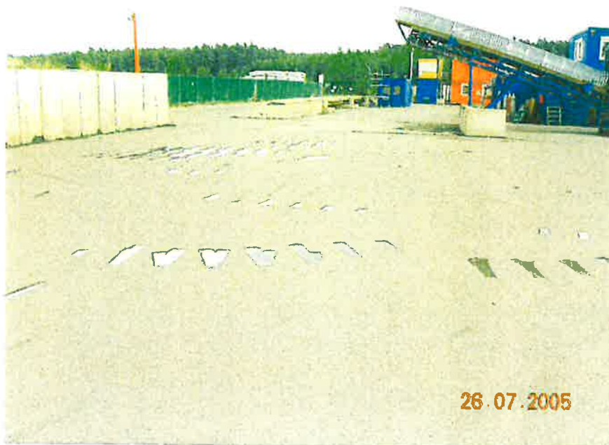
Bild Nr. 5: Oberfläche Abschürfungen ohne Beeinträchtigung der Dichtigkeit
