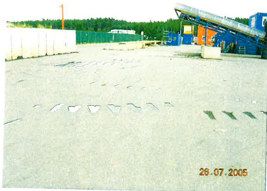
Bild Nr. 4: Oberfläche Abschürfungen ohne Beeinträchtigung der Dichtigkeit
